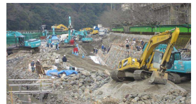
喜撰橋上流の宇治川改修工事現場
